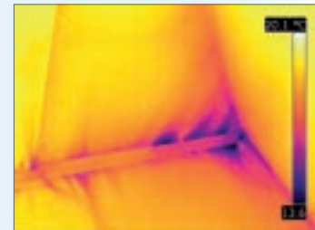
Termograma durante un test BlowerDoor
