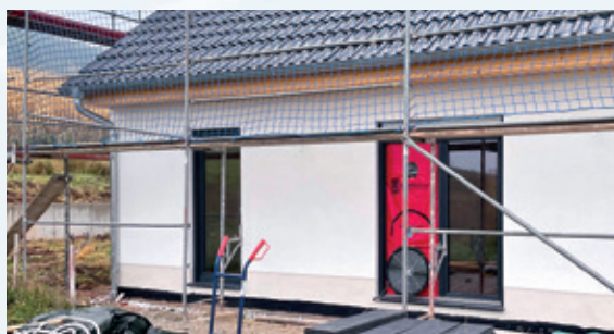
Medición BlowerDoor en un edificio nuevo
