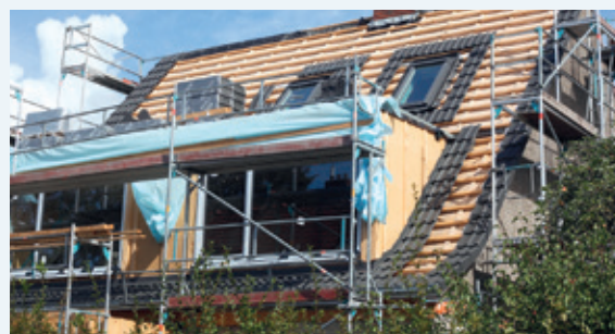
La estanqueidad al aire en los edificios existentes también ofrece un gran potencial para evitar daños en la construcción y ahorrar energía
